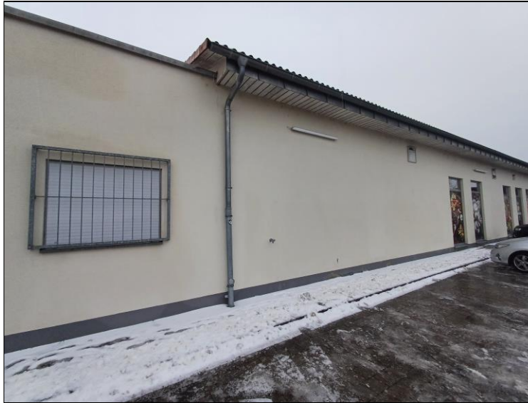
Abbildung 5: Supermarkt-Gebäude ohne jede Form von Gebäudehabitate
