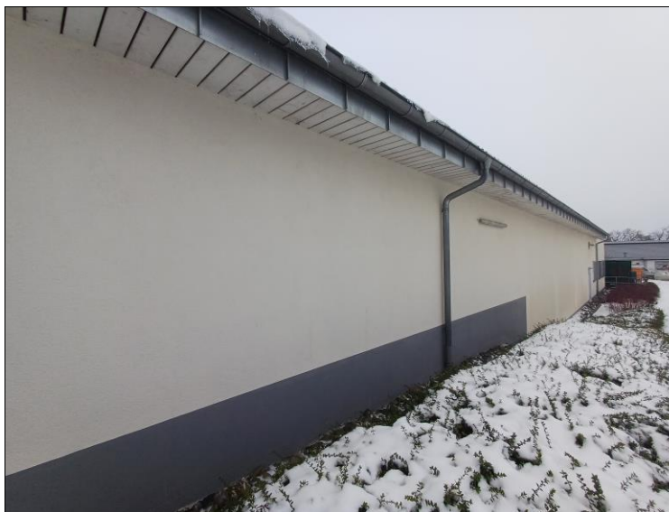
Abbildung 4: Supermarkt-Gebäude ohne jede Form von Gebäudehabitate
